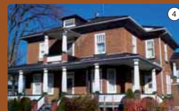
3 • Maison de style cubique datant de 1917, comportant une toiture à quatre versants, dite à « quatre-eaux ». Cette dernière arbore un revêtement en bardeau de cèdre comportant des motifs.
