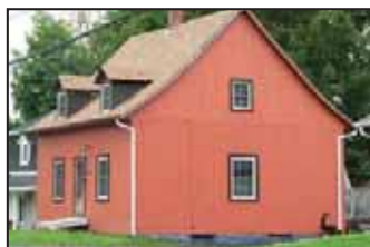
Maison québécoise datant de 1879 et située sur la rue principale.
