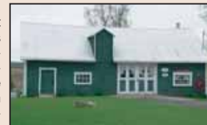
Forge Demers située au 305, rue Principale
